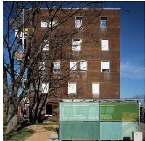
Bild 4.34: Ostfassade Haus 2 mit Stahlbekleidung
