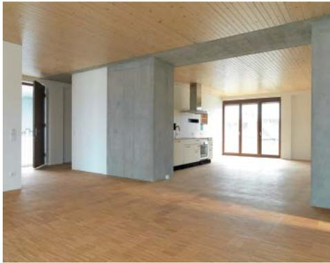
Bild 4.11 Offener Wohnbereich mit Stahlbetonstützen und -unterzug
