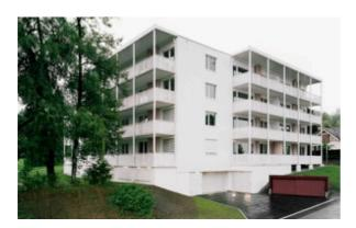
Der Architekt setzte mit seiner **Kostenstrategie** bei der Geometrie und Baustruktur an: Elemente, ohne entscheidende Bedeutung für die architektonische Qualität, wurden konsequent auf das Minimum reduziert, z.B. bei Liftanlagen oder Leitungsschächten oder dem auf Decken und Wohnungstrennwände beschränkten Einsatz von Beton.
