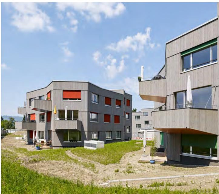
Die Wohnüberbauung erfüllt den Standard Minergie-P und die Ziele der 2000-Watt-Gesellschaft gemäss SIA-Effizienzpfad, mit ihrer kompakten Gebäudeform und der Mischbauweise von Massivbau und tragenden Aussenwandelementen aus Holz. Die Haustechnik ist in kompakten Schächten mit möglichst geringen Leitungslängen und wenigen Abzweigungen konzipiert, was eine preisbewusste Bauweise ermöglicht.
